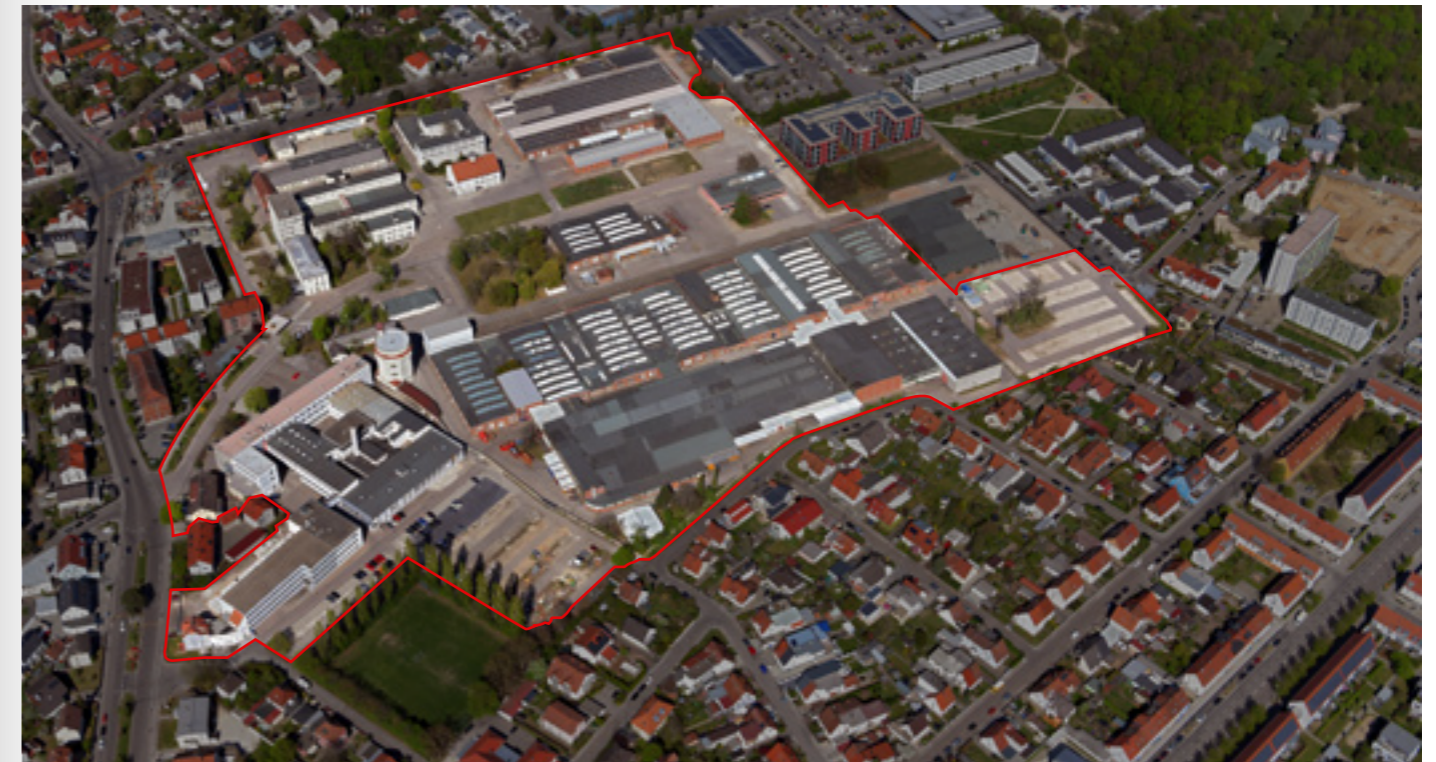
Abgrenzung INquartier vor den Rückbaumaßnahmen
